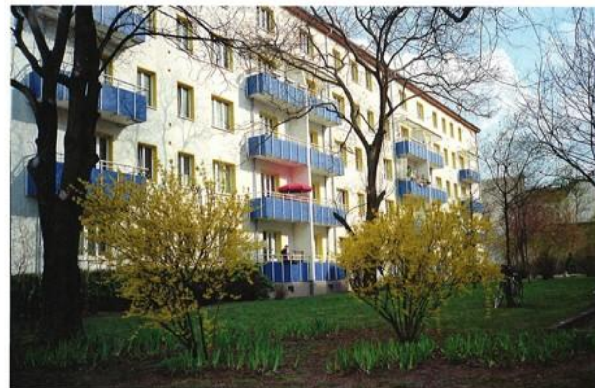
Жилой дом, Invalidenstraße
