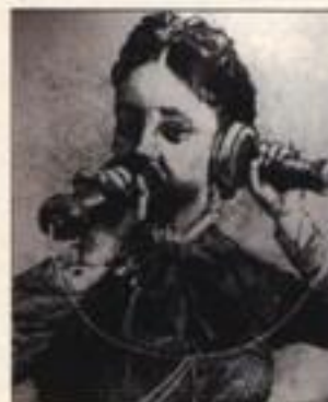
ТЕЛЕФОННЫЙ АППАРАТ В РУКАХ У ЭТОЙ МИЛОЙ БАРЫШНИ ИЗОБРЕЛ ЭДИСОН. В ОТЛИЧИЕ ОТ ТРУБКИ БЕЛЛА, ОН СОСТОИТ ИЗ ДВУХ ОТДЕЛЬНЫХ ЧАСТЕЙ — НАУШНИКА И МИКРОФОНА
