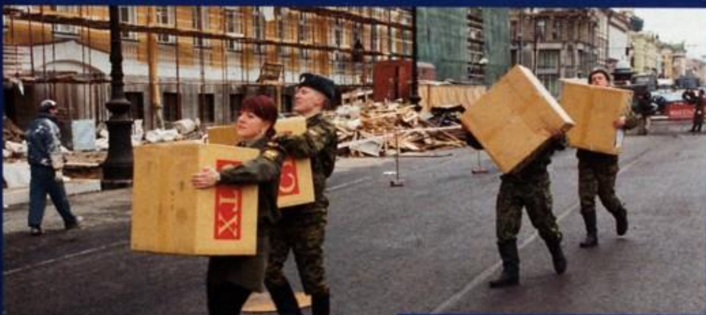
РЕМОНТ В ИСТОРИЧЕСКОМ ЦЕНТРЕ – КАТАСТРОФА ДЛЯ РАСПОЛОЖЕННЫХ ТАМ УЧРЕЖДЕНИЙ. НА ФОТО: ПЕРЕД ЗДАНИЕМ ГЛАВНОГО ШТАБА НА ДВОРЦОВОЙ. ВВЕРХУ: МИЛЛИОННАЯ УЛИЦА (ОТ ДВОРЦОВОЙ ПЛОЩАДИ К МАРСОВУ ПОЛЮ)
