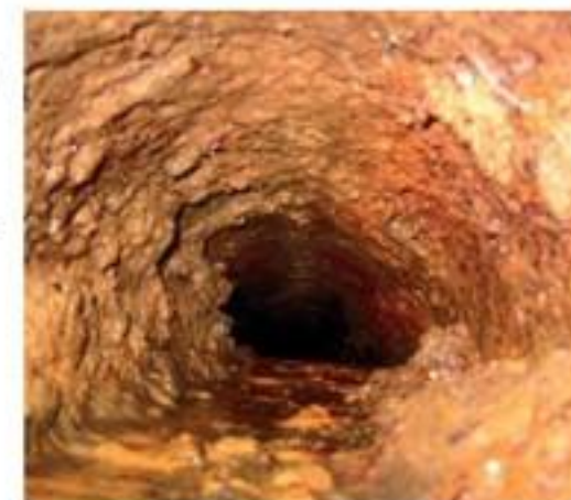
Труба до и после прочистки
